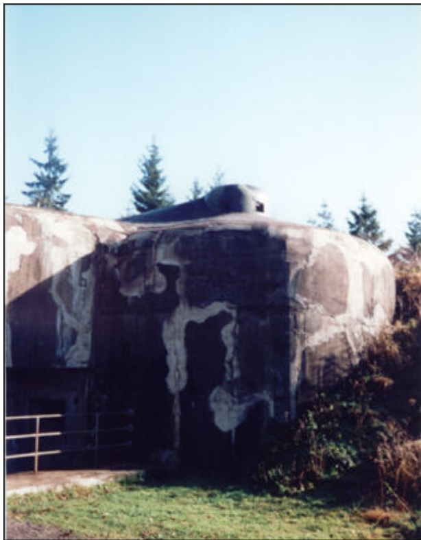
Widok na bunkier R-S76. Po lewej stronie - za barierką - widoczna fosa, w której jest wejście do bunkra.
